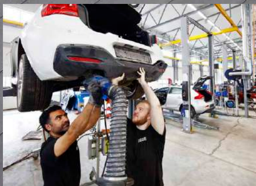
Avgaser sugs ut med hjälp av lösning installerat av VentPartner.
